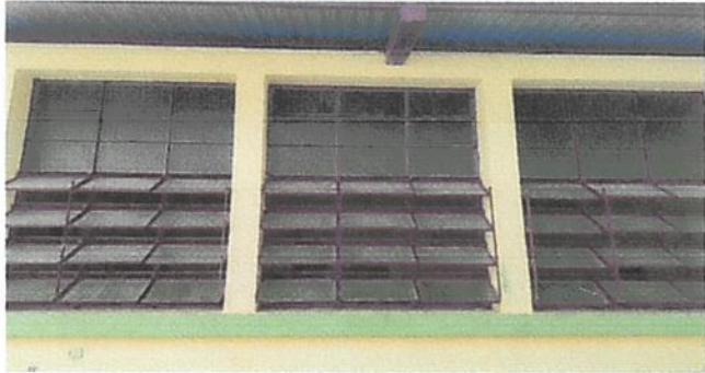
Foto 7. Sustitución de ventanas.
