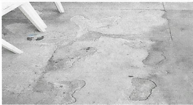
Foto 9. Reparación de plancha.
