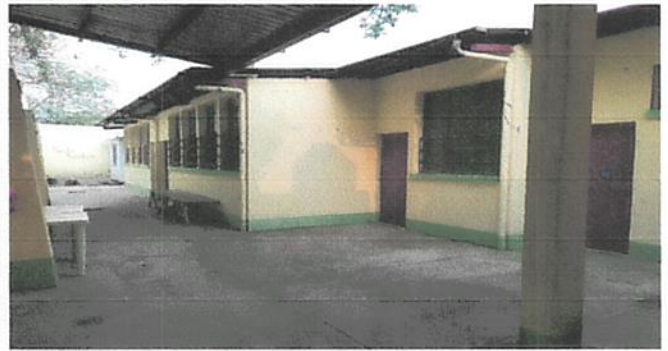
Foto. 10 Pintura en muros exteriores e interiores.
